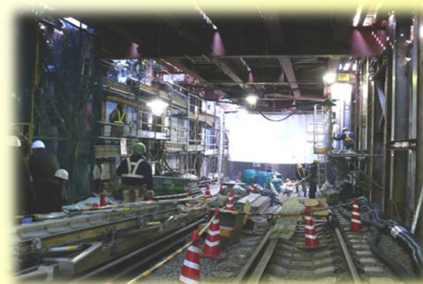
東急東横線地下化工事
